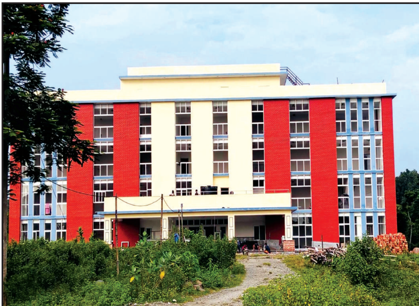
पथरीशनिश्चरे नगरपालिकाको निर्माणाधिन प्रशासनिक भवन
