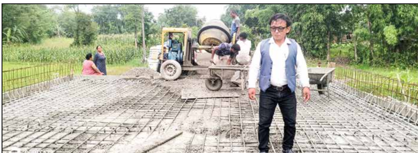
वडा नं. ३ द्वारा वडा नं. २ र ३ को सिमानाको कल्भर्ट निर्माणको अनुगमन
